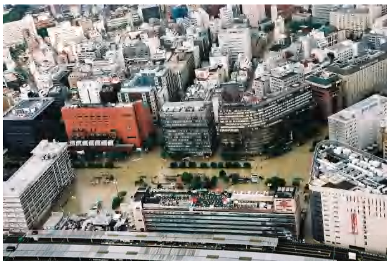
博多駅周辺の浸水状況
