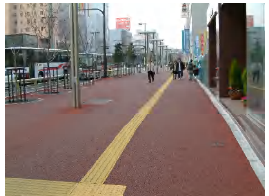
渡辺通り 透水性舗装（歩道部）
