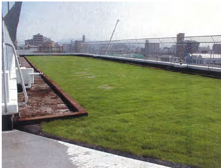
屋上緑化（市営笹松二丁目住宅）
